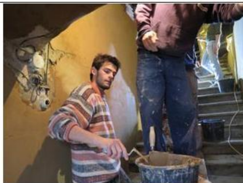
omítání stěny schodiště
