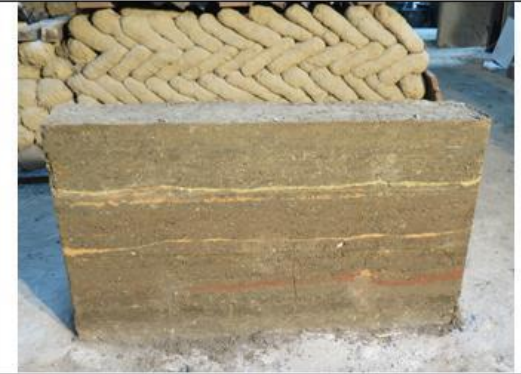
hotová stěna (v pozadí stěna z válků)
