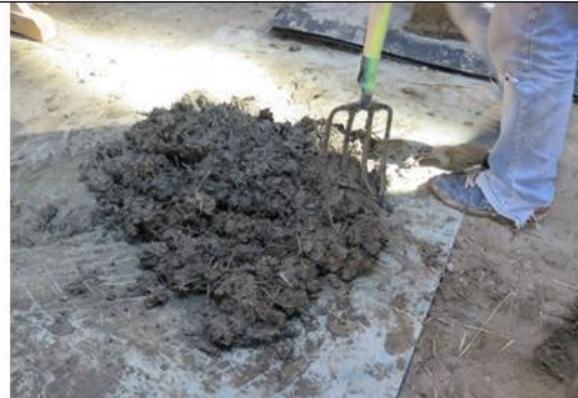
příprava hliněné směsi pro vrstvení
