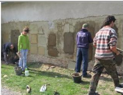
provádění zkušebních desek
