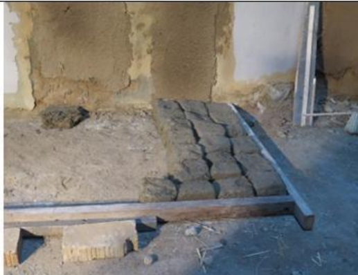
provádění podlahy tradičním způsobem
