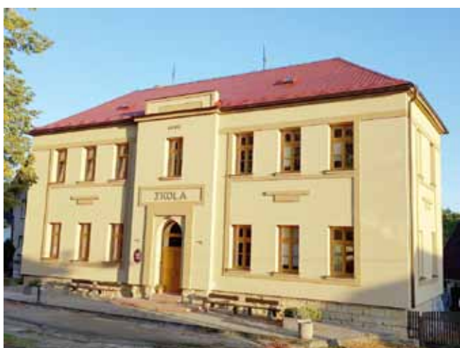
ZŠ - Průčelí budovy po dokončení
