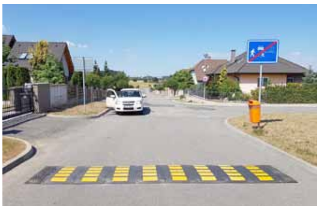
Zpomalovací pruhy - Nová zástavba
