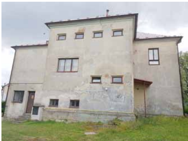
ZŠ - před zahájením Rekonstrukce - zadní část
