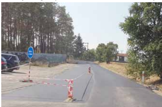
Oprava úseku Hlavní silnice III. třídy Před dokončením
