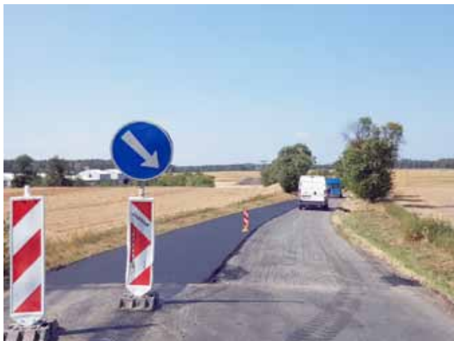
Zahájení opravy úseku Hlavní silnice III. třídy
