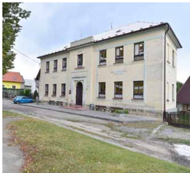
ZŠ - před zahájením Rekonstrukce
